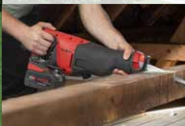
La scie sabre se distingue tout spécialement pour sa facilité d'application dans des travaux de démolition rapides et exigeants.
