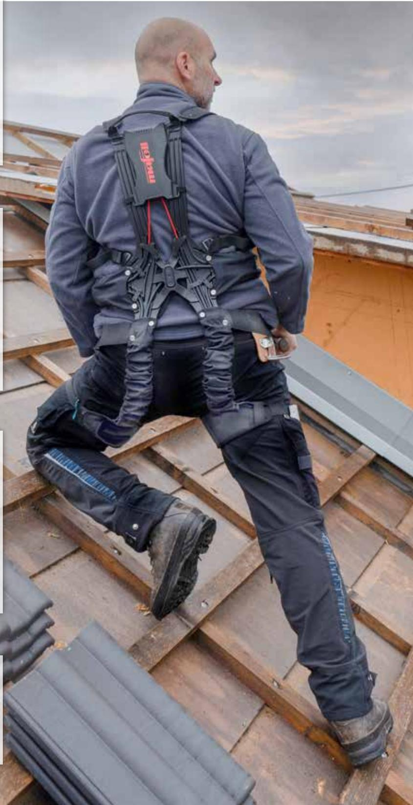
**Gelernt von der Natur unter Erhaltung der natürlichen Struktur ist das BionicBack eine körpergetragene Beuge- und Hebehilfe. Es fördert die körperliche Entlastung und Unterstützung der tragenden Person. Die innovative Technologie wurde speziell dafür entworfen, den Benutzers bei seinen Bewegungen zu unterstützen.**
